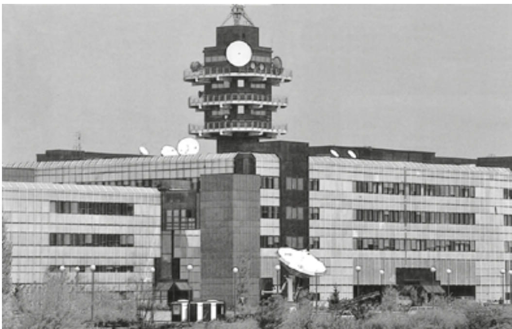
Udar sleđa - Zgrada hrvatske radiotelevizije (Izvor: Hrvatske enclikopedia - mrežno izdanje)
